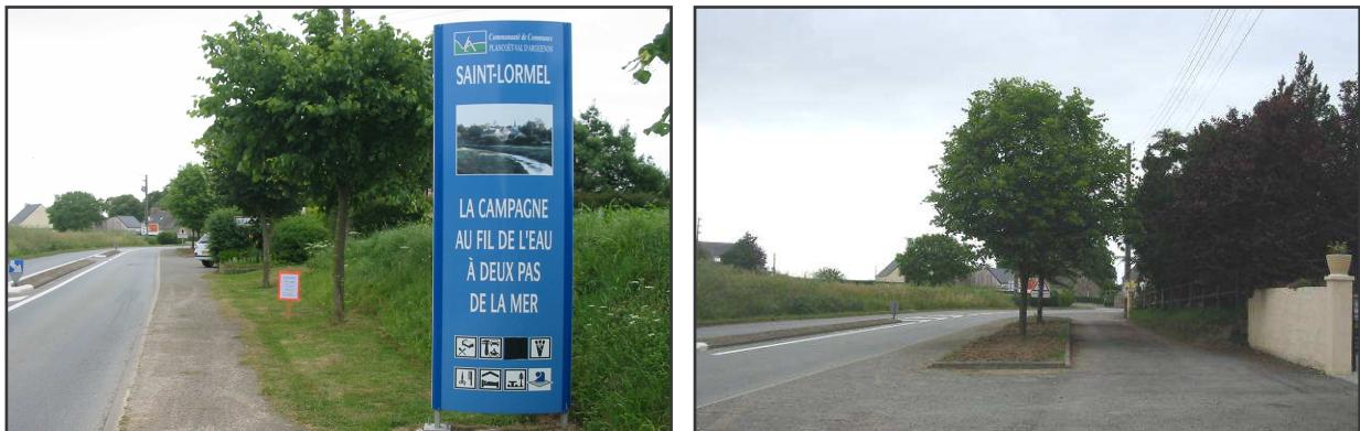
L'entrée Nord Est traitée sensiblement de la même façon que l'entrée Sud. Sur la rive Ouest une contre allée, séparée de la route par une bande arborée, permet un cheminement sécurisé des piétons et des cycles, une sortie protégée des maisons riveraines, ou un espace d'arrêt ou de stationnement temporaire, en dehors de la chaussée.
